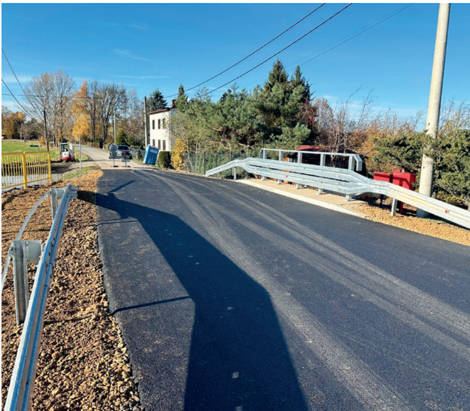
Wyremontowany przepust przy ul. Młyńskiej w Kaniowie
